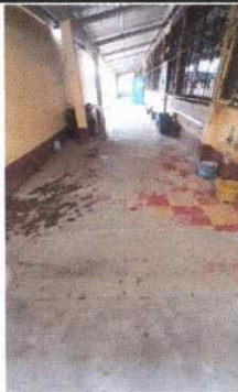
Foto 5: Se observa que el piso de granito ha ido deteriorandose y separandose del suelo, por lo que se ve ya el cemento del suelo, del modulo No. 3, se requiere sustitución
