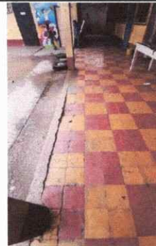
Foto 6: Se observa que el corredor del modulo No. 3 tiene un hundimiento por lo que el piso de granito se ha arruinado, se requiere sustitución
